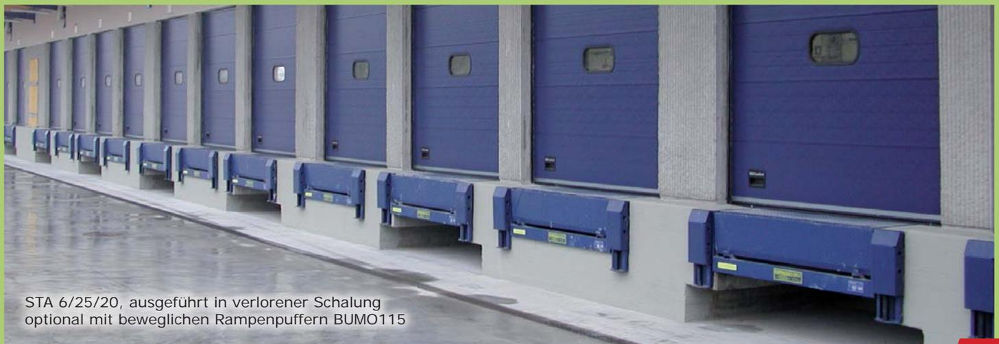
STA 6/25/20, ausgeführt in verlorener Schalung optional mit beweglichen Rampenpuffern BUMO115
