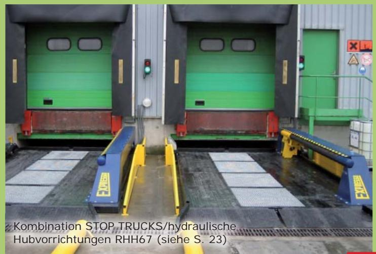
Kombination STOP TRUCKS/hydraulische Hubvorrichtungen RHH67 (siehe S. 23)
