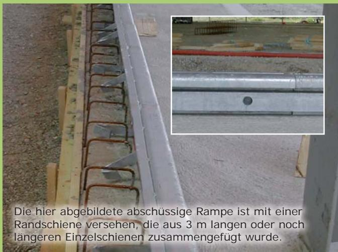
Die hier abgebildete abschüssige Rampe ist mit einer Randschiene versehen, die aus 3 m langen oder noch längeren Einzelschienen zusammengefügt wurde.
