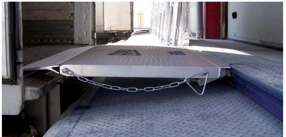
Bei im Bau befindlichen Laderampen bieten sich durch die Schaffung eines Abhangs (wie nebenstehend abgebildet) gewisse Vorteile: die Schiene kann bündig am senkrechten Teil der Rampe angebracht werden, wodurch die Sturzgefahr bei Fehlritten vermieden werden kann. Außerdem werden auf diese Weise Schiene und Überladebrücke vor Schäden bei Rangierfehlern der Fahrzeuge geschützt.
