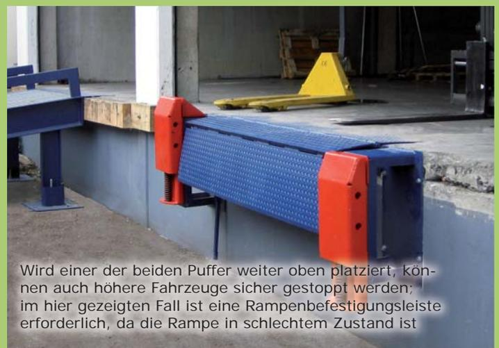
Wird einer der beiden Puffer weiter oben platziert, können auch höhere Fahrzeuge sicher gestoppt werden; im hier gezeigten Fall ist eine Rampenbefestigungsleiste erforderlich, da die Rampe in schlechtem Zustand ist
