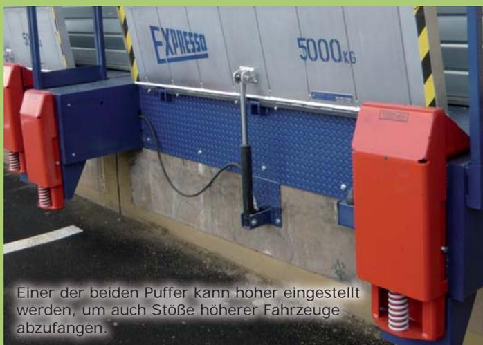
Einer der beiden Puffer kann höher eingestellt werden, um auch Stöße höherer Fahrzeuge abzufangen.
