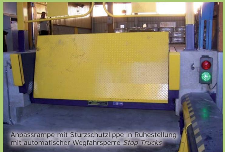
Anpassrampe mit Sturzschutzlippe in Ruhestellung mit automatischer Wegfahrsperrung *Stop Trucks*
