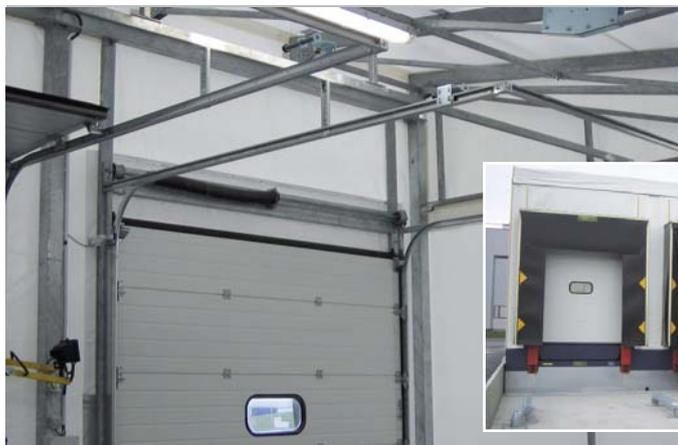
8 x 8 m-Plattform mit Gerüst und Planenverkleidung + 2 Ladebuchten (Tor, Anpassrampe, Torabdichtung).
