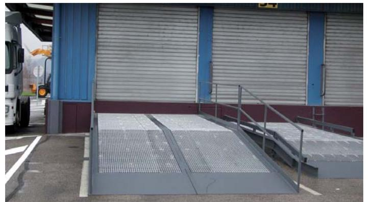
Wird immer der gleiche Fahrzeugtyp be- und entladen, können speziell an die Abmessungen dieses Fahrzeugtyps angepasste, zweiteilige Rampen verwendet werden. Ist dies nicht der Fall, ist die Installation einer Monoblockrampe empfehlenswert, die bei jedwedem Leicht-Lkw- oder Transportertyp für bequeme Arbeitsbedingungen und Benutzersicherheit sorgt.
