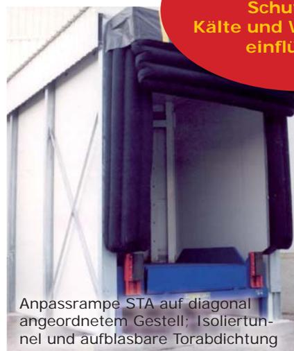
Anpassrampe STA auf diagonal angeordnetem Gestell; Isoliertunnel und aufblasbare Torabdichtung
