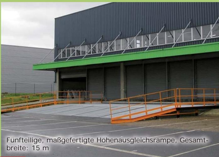
Fünfteilige, maßgefertigte Höhenausgleichsrampe, Gesamtbreite: 15 m
